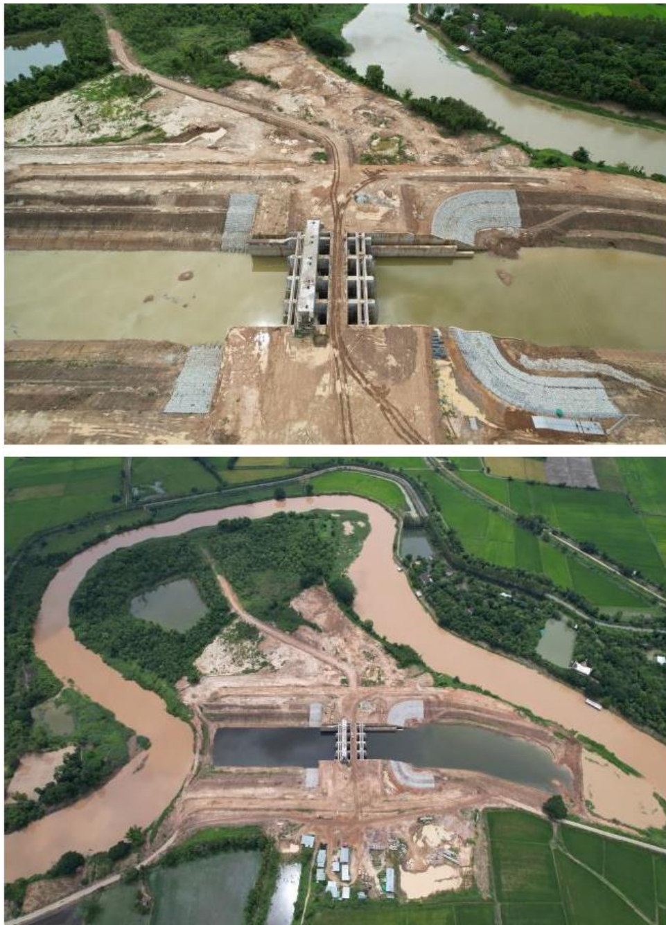
ภาพที่ 1-3 การก่อสร้างประตูระบายน้ำและอาคารประกอบ
